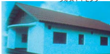
地域学習センター(CLC)と保育園の隣接地にITセンターを建設(2008)
