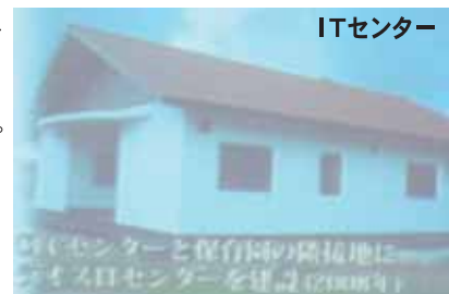
ITセンター 地域学習センター(CLC)と保育園の隣接地にITセンターを建設(2008)。今期農業支援センター建設のプロジェクトに理解と支援を!
